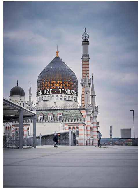
Abb. 2, ehem. Fabrikgebäude für Tabakwaren „Yenidze“ in Dresden, erbaut Anfang des 20. Jh. im orientalisierten Stil Quelle (https://unsplash.com/photos/8ZPiJdSd6Rg)
