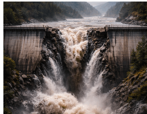
Abb. 14, Entgrenzungsbefürchtung: Furcht davor, dass der Damm bricht; KI-generiert (ChatGPT)
